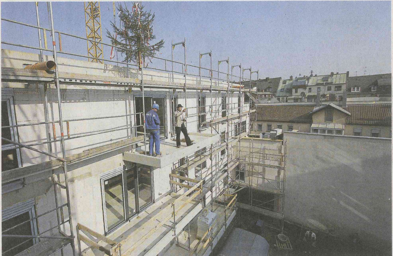
Zimmermann Nico Richter (re.) trägt auf einem Balkon im zweiten Stock nach altem Brauch den Richtspruch vor und leert das Weinglas mit Elan auf Bauherrn und Gebäude. Foto: Edgar Pfrogner
